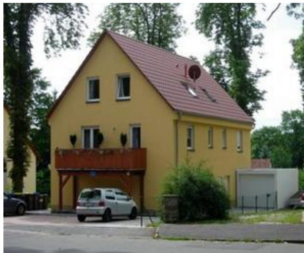
Blick von Nordwesten
