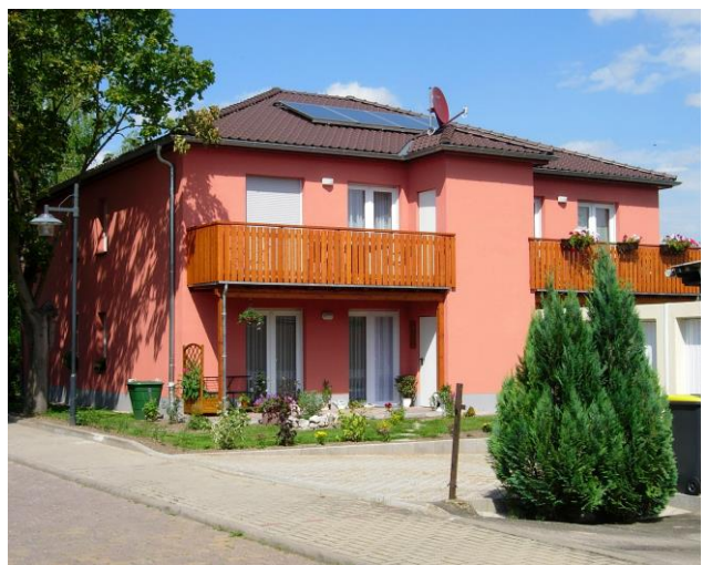
Blick von Südwesten
