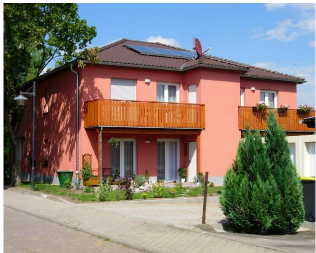
Blick von Südwesten
